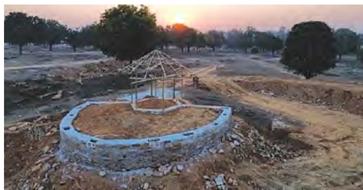
गोल झोपड़ी का निर्माण
